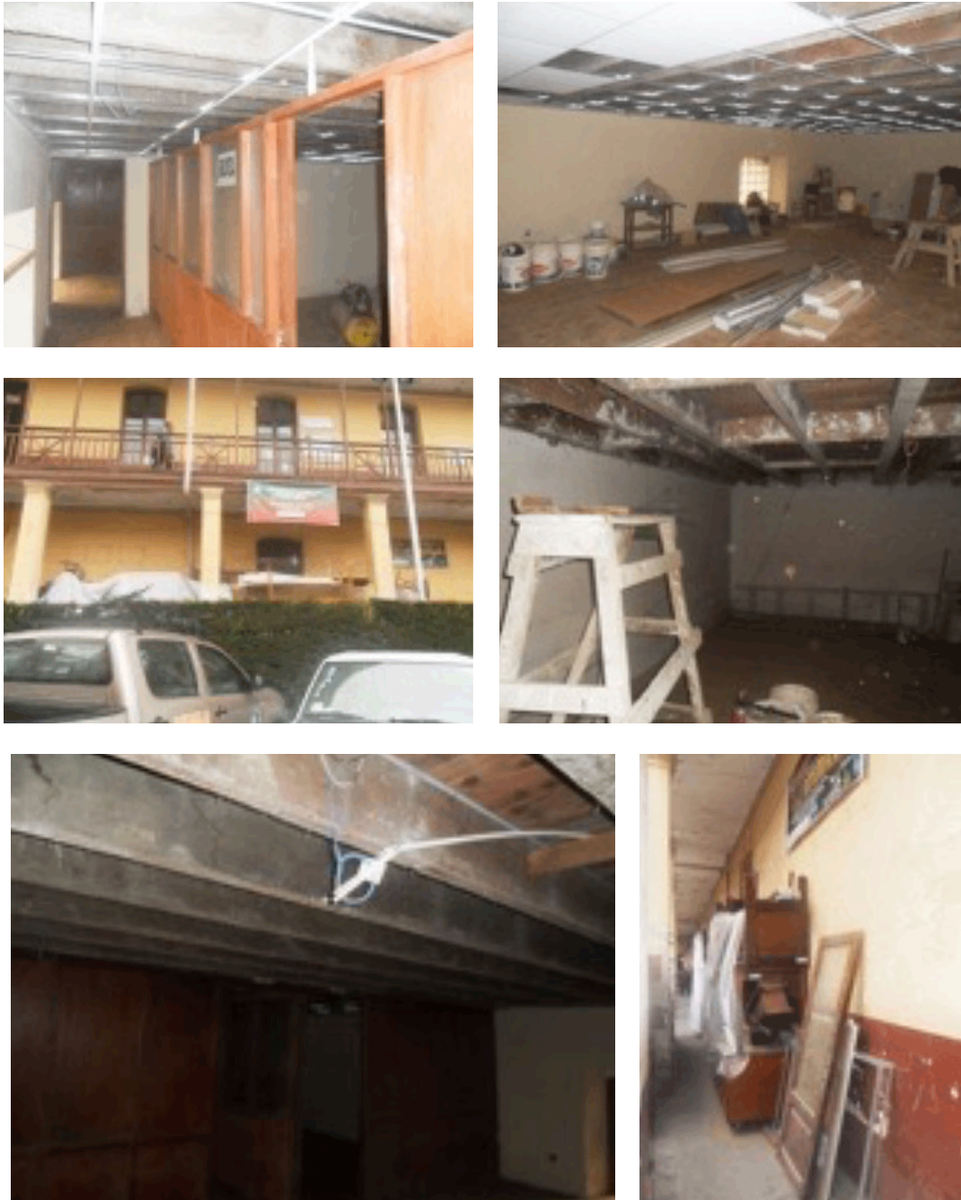
Figura 9.4: Refacción de las oficinas de Matemática en el predio central
